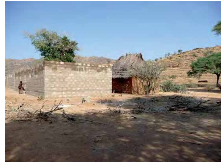
Neubau der Grundschule in Kauda 1998
